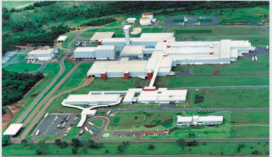
Perdigão: Schon während der Planung des komplexen fleischverarbeitenden Betriebes wurden die zukünftigen Erweiterungsoptionen angedacht und die Werksinfrastruktur entsprechend ausgelegt.
