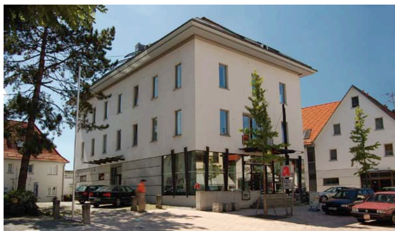
Das Fachplanungsbüro ist auf insgesamt vier Geschossen untergebracht.
