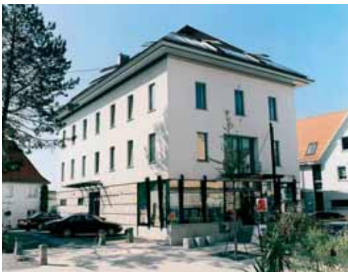
Im Aulendorfer Architekturbüro hat Falkenstein in den letzten 50 Jahren über 250 Betriebe geplant und realisiert.
